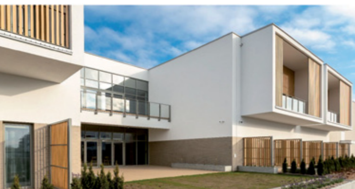
Budynek Domu Pomocy Społecznej w Poznaniu ul. Żołnierskiej Wyklętych
